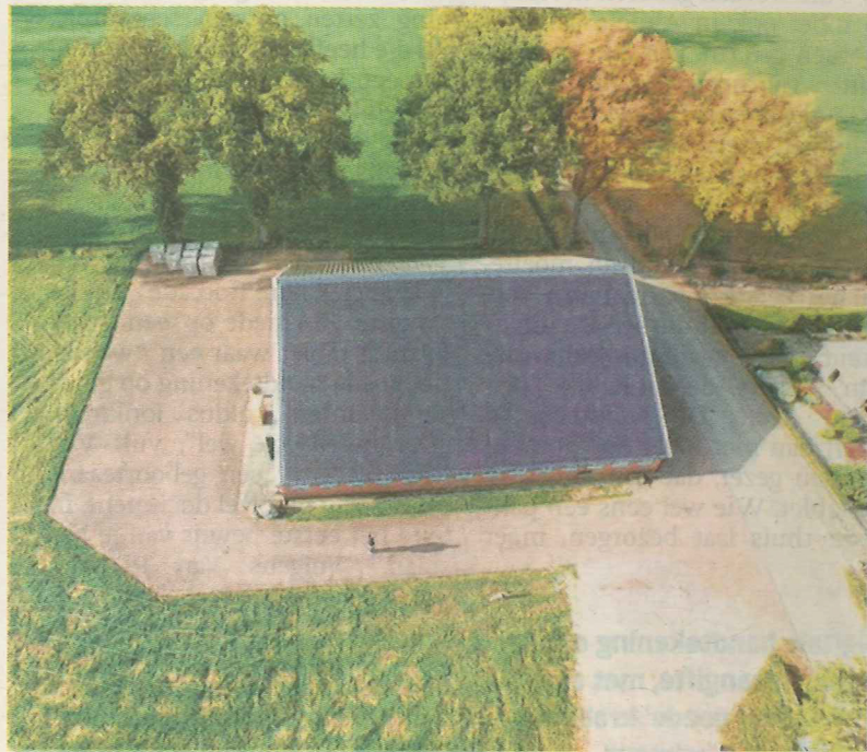
● Het dak van de opslagruimte bij Rent-a-Tent ligt al vol zonnepanelen.
